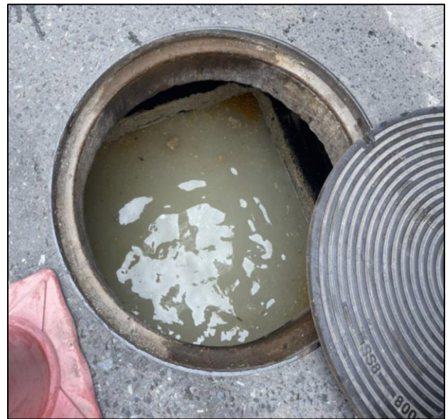
รูปที่ 2-27 การตัดไขมันจากบ่อดักไขมัน
